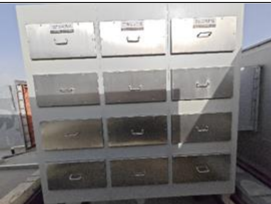
实验中心 Px-2 排气筒前端“活性炭吸附”装置
