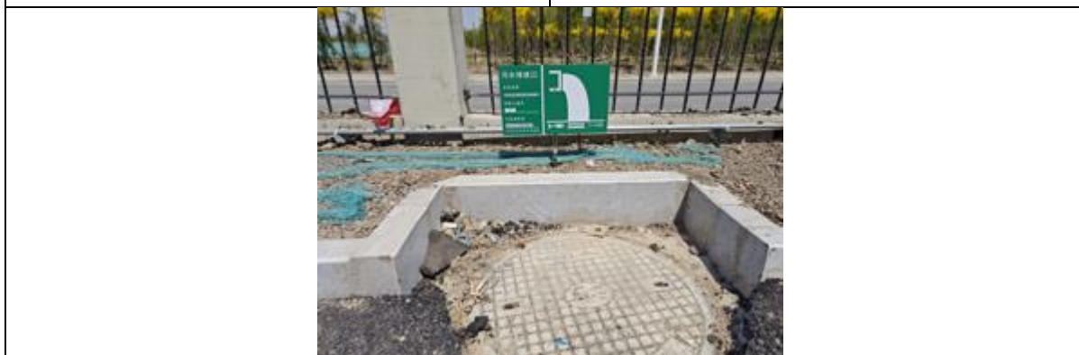
依托污水排口 DW001
