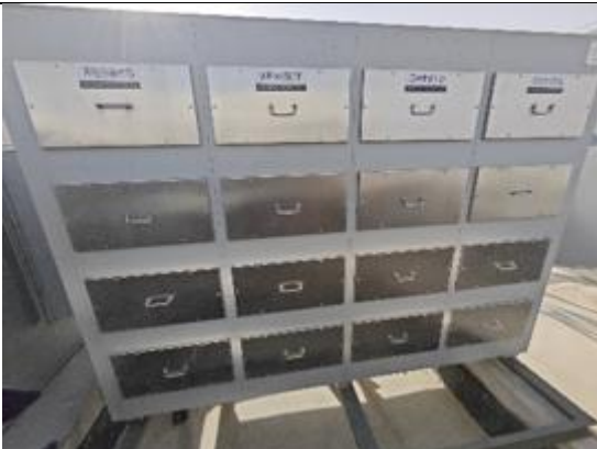
实验中心 Px-2 排气筒前端“活性炭吸附”装置
